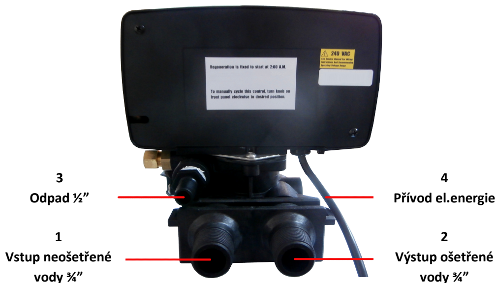
Obr. 2. Spojení na řídicí hlavici
